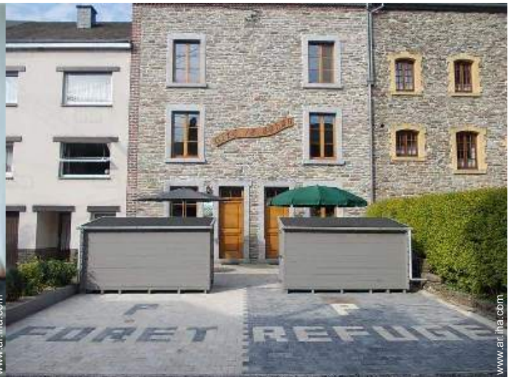
Marco exterior a disposición de los huéspedes
