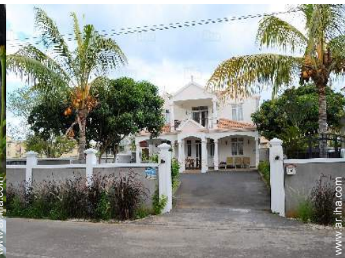
vista sobre la calle/la avenida
