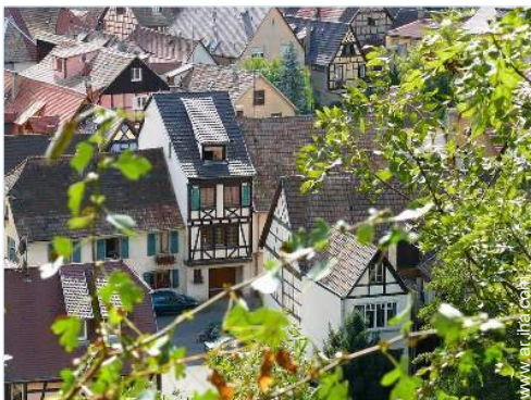
vista de conjunto
